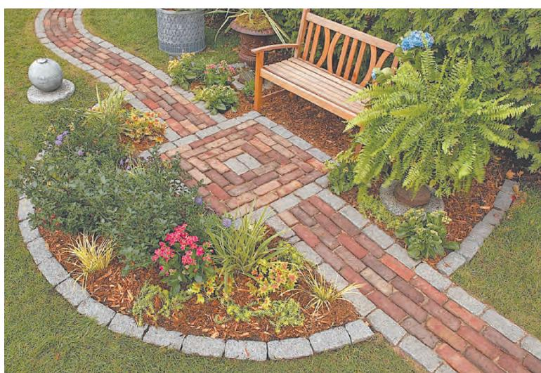
Мощение жестких садовых дорожек проходит по единой схеме: разметка линии дорожек, снятие грунта, заложение многослойного «фундамента», укладка материала поверхности.
